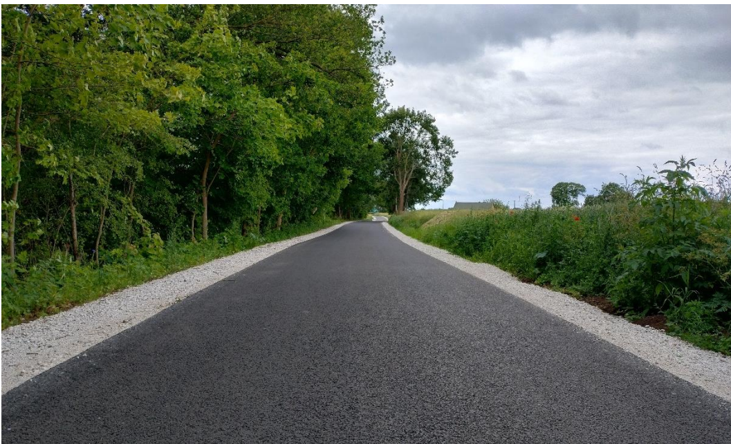
Fot. nr 12 Remont drogi powiatowej nr 1273C Luszkówko - Zbrachlin, źródło: własne
