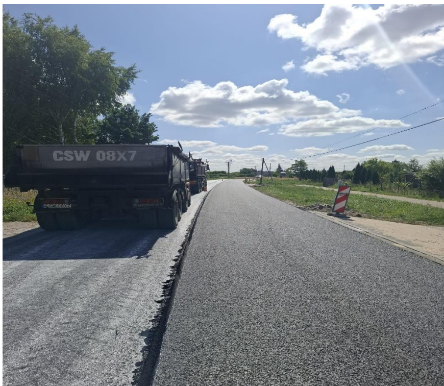
Fot. nr 33 Przebudowa odcinka drogi powiatowej nr 1260C Kozłowo - Przechowo, źródło: własne
