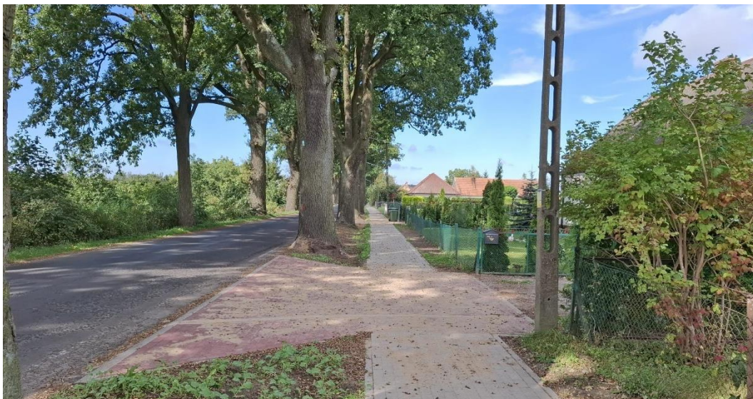
Fot. nr 38 Budowa chodnika przy drodze powiatowej nr 1049C w Łowinku, źródło: własne
