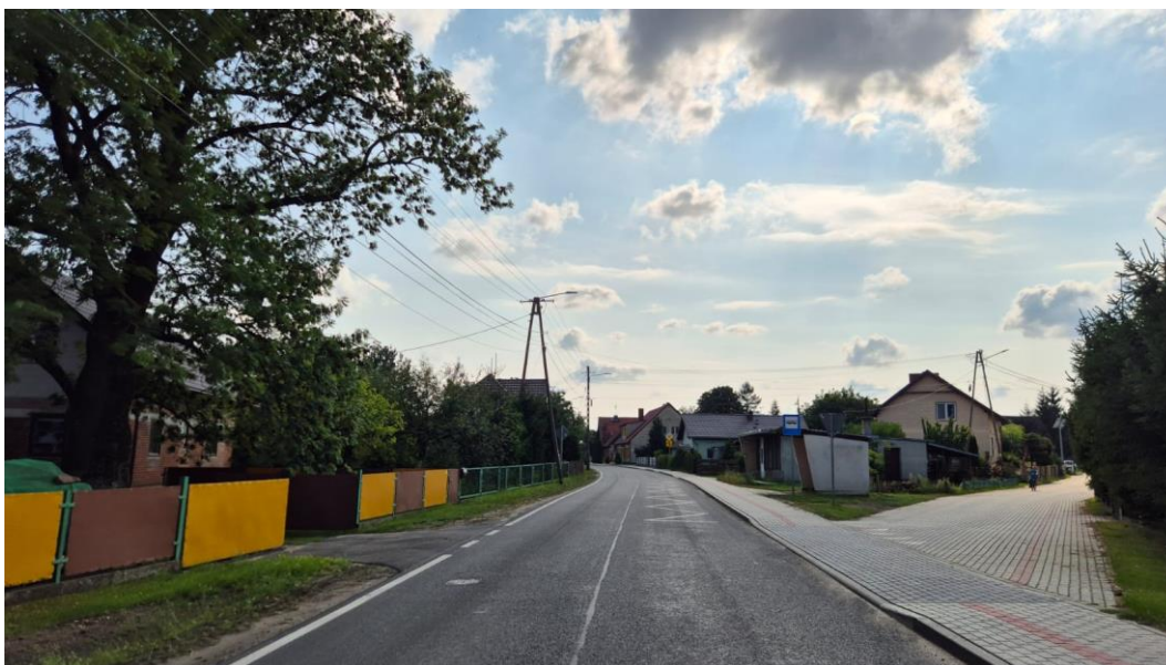
Fot. nr 22 Przebudowa drogi powiatowej nr 1041C Błądzim – Świekatowo, źródło: własne
