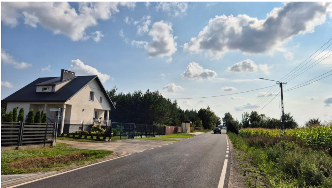
Fot. nr 25 Przebudowa drogi powiatowej nr 1041C Błędzim – Świekatowo, źródło: własne
