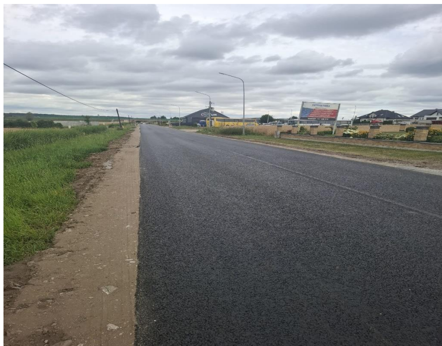
Fot. nr 32 Przebudowa odcinka drogi powiatowej nr 1260C Kozłowo - Przechowo, źródło: własne
