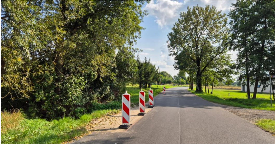
Fot. nr 41 Wygrodzenie pasa ruchu w celu wykonania wymiany konstrukcji nawierzchni bitumicznej, źródło: własne
