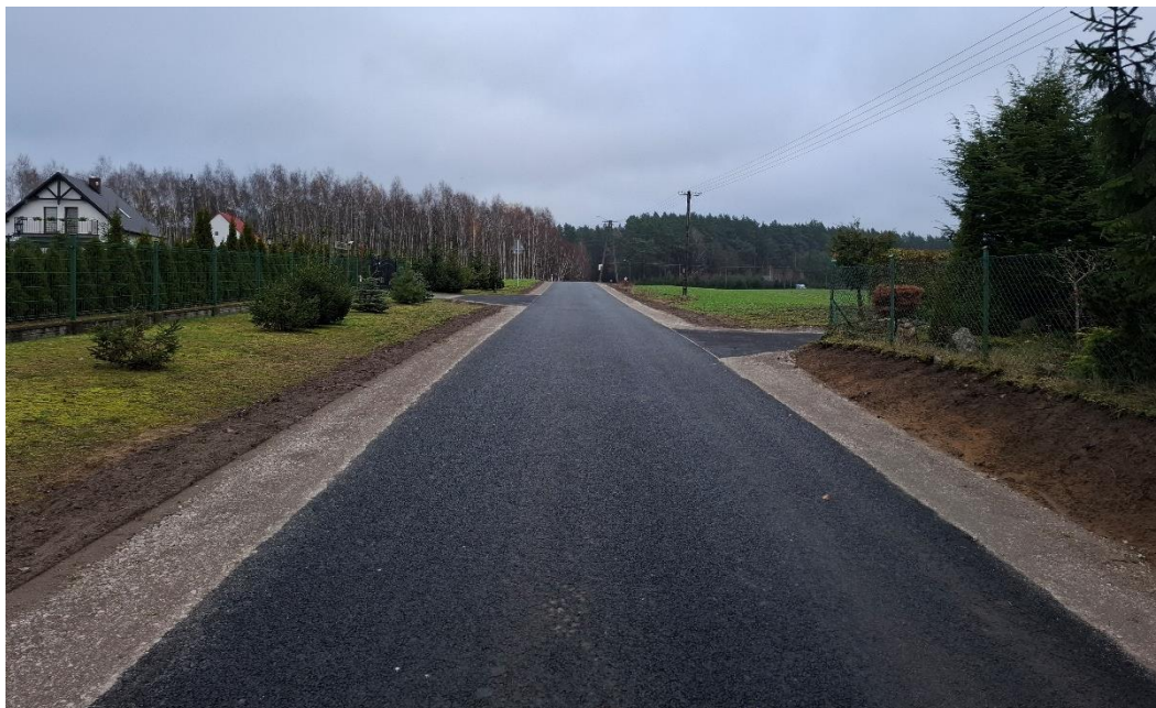
Fot. nr 40 Przebudowa drogi powiatowej nr 1227C, źródło: własne
