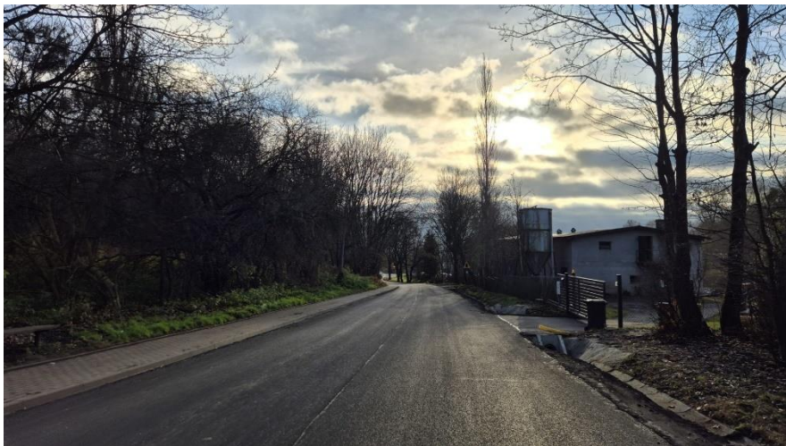
Fot. nr 34 Przebudowa drogi powiatowej nr 1218C, źródło: własne
