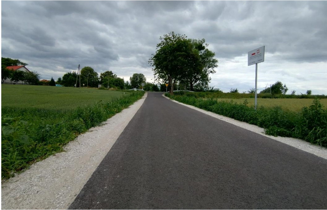
Fot. nr 11 Remont drogi powiatowej nr 1273C Luszkówko - Zbrachlin, źródło: własne
