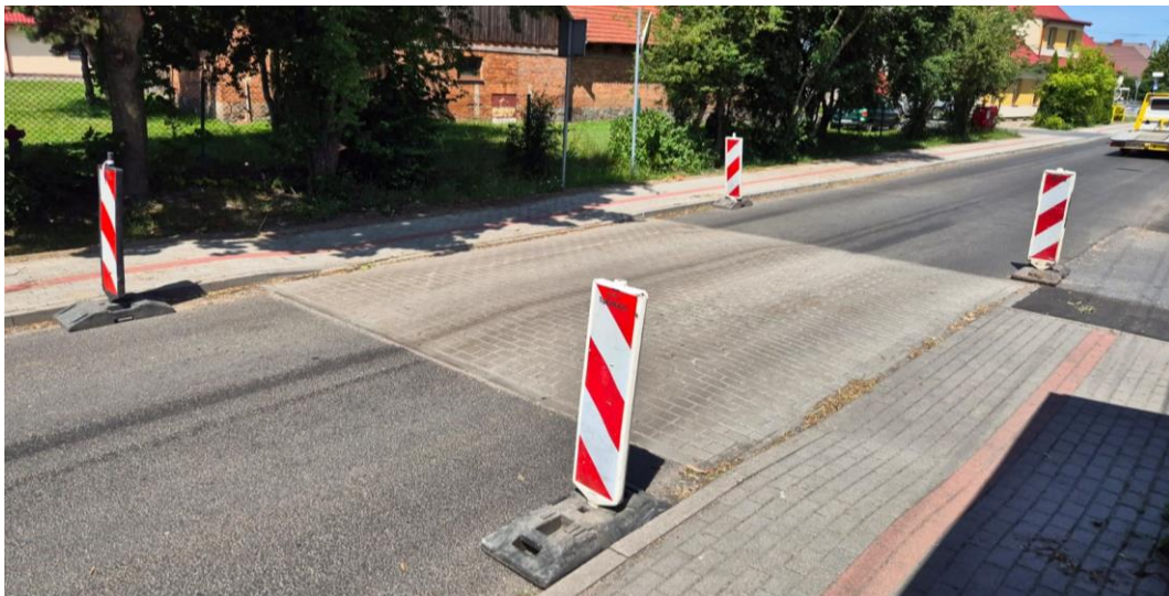
Fot. nr 21 Przebudowa drogi powiatowej nr 1041C Błędzim – Świekatowo, źródło: własne
