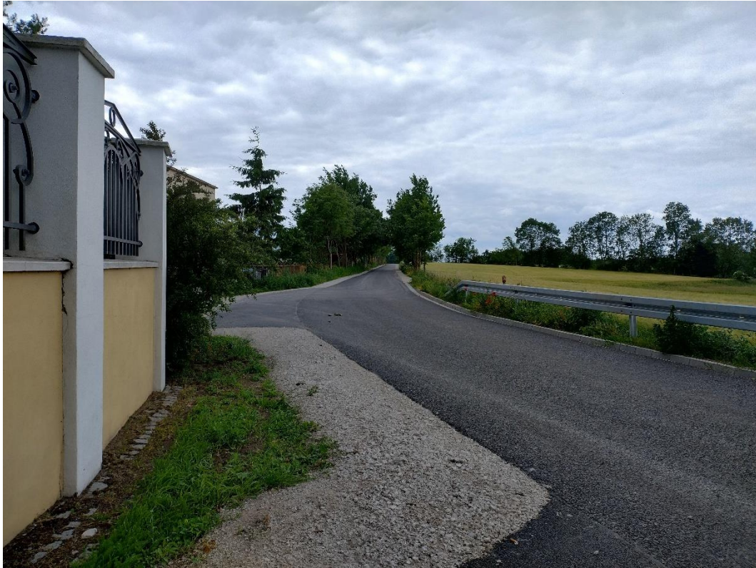
Fot. nr 13 Remont drogi powiatowej nr 1273C Luszkówko - Zbrachlin, źródło: własne
