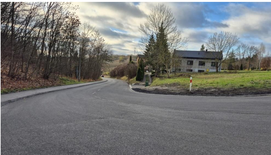
Fot. nr 36 Przebudowa drogi powiatowej nr 1218C, źródło: własne
