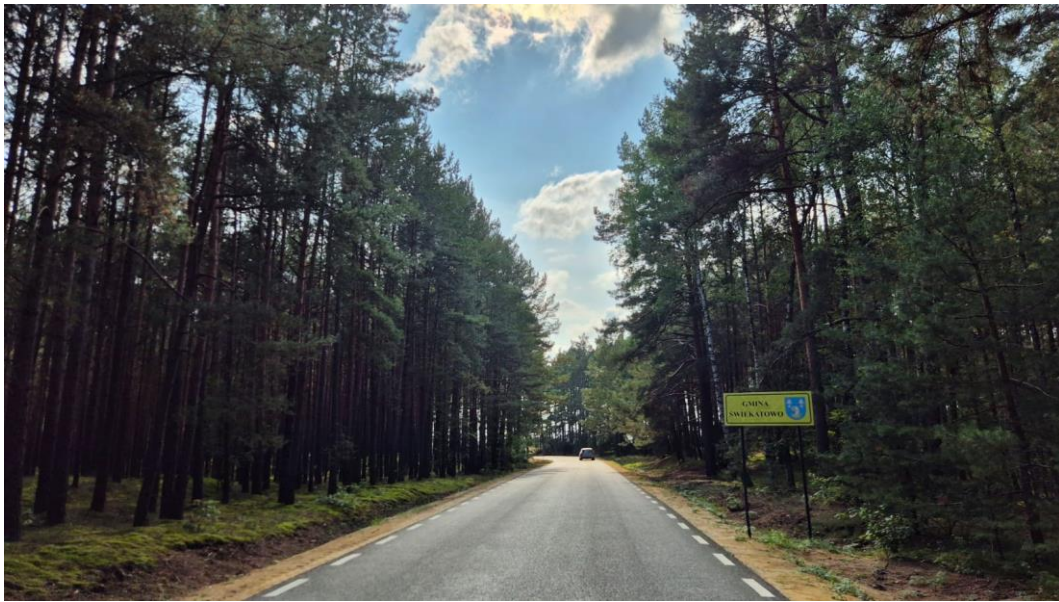
Fot. nr 26 Przebudowa drogi powiatowej nr 1041C Błądzim – Świekatowo, źródło: własne
