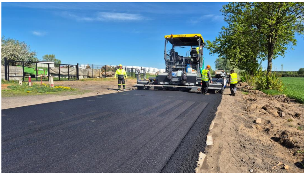
Fot. nr 19 Przebudowa drogi powiatowej nr 1041C Błądzim – Świekatowo, źródło: własne
