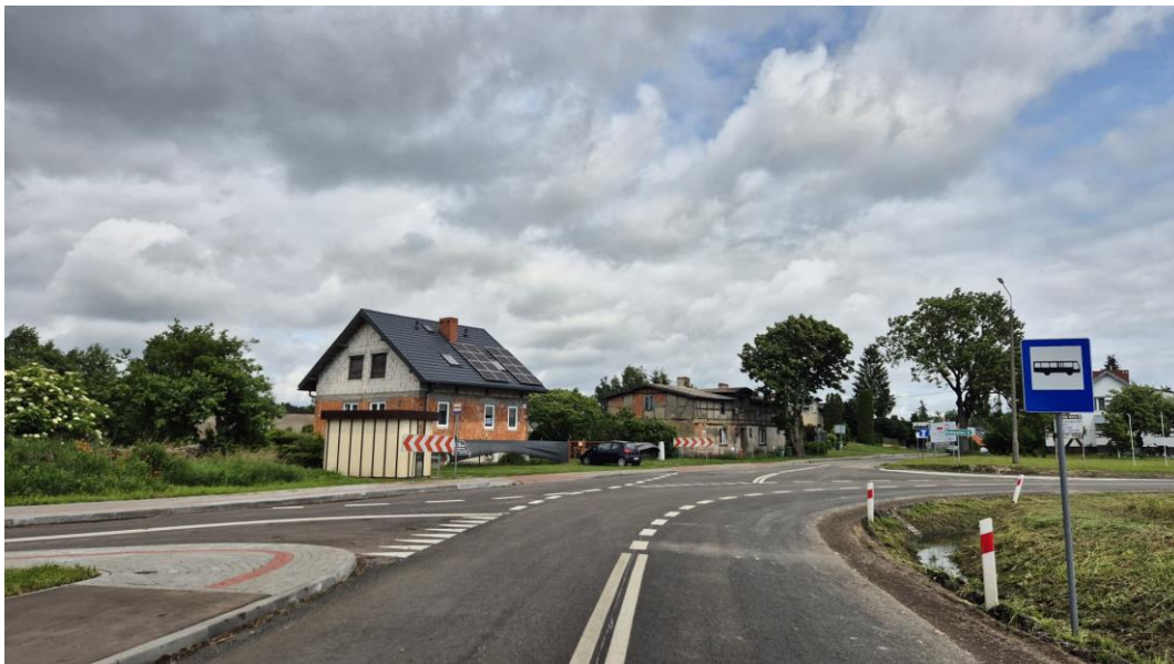
Fot. nr 27 Remont odcinka drogi powiatowej nr 1263C Świekatowo – Bukowiec, źródło: własne
