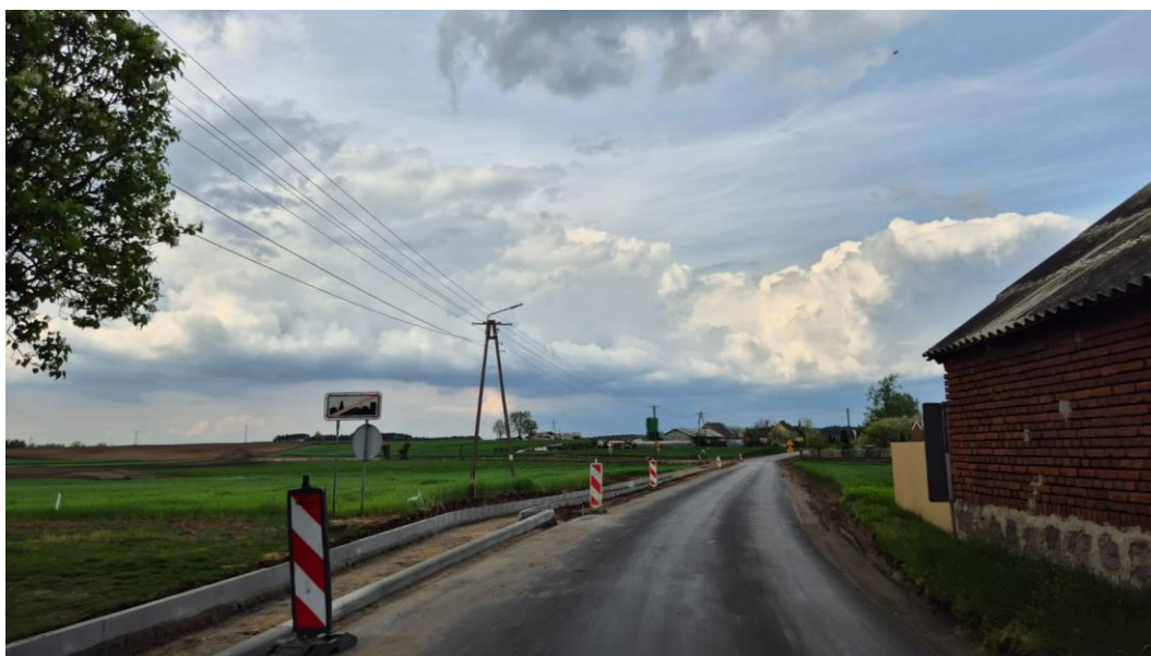
Fot. nr 18 Przebudowa drogi powiatowej nr 1041C Błądzim – Świekatowo, źródło: własne
