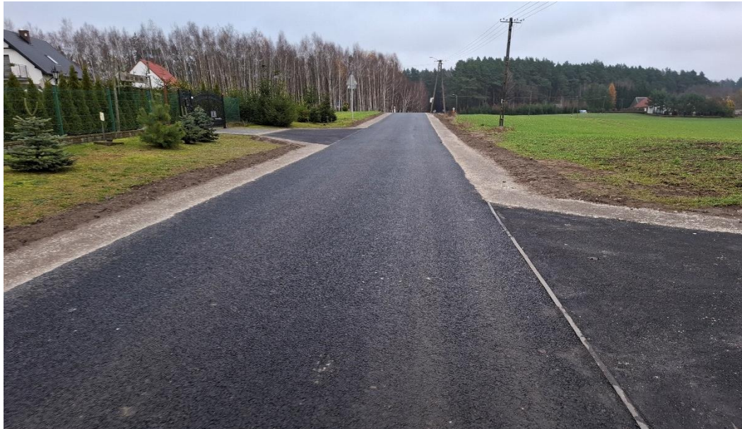
Fot. nr 39 Przebudowa drogi powiatowej nr 1227C, źródło: własne
