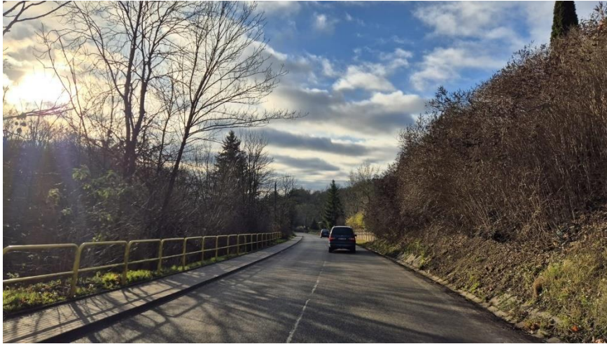
Fot. nr 35 Przebudowa drogi powiatowej nr 1218C, źródło: własne
