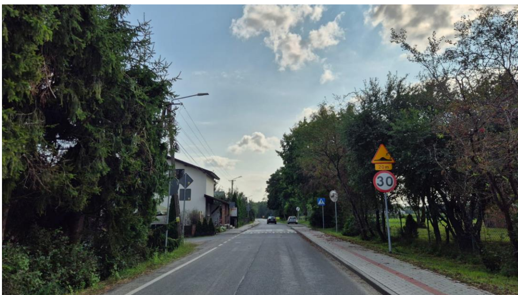
Fot. nr 23 Przebudowa drogi powiatowej nr 1041C Błądzim – Świekatowo, źródło: własne
