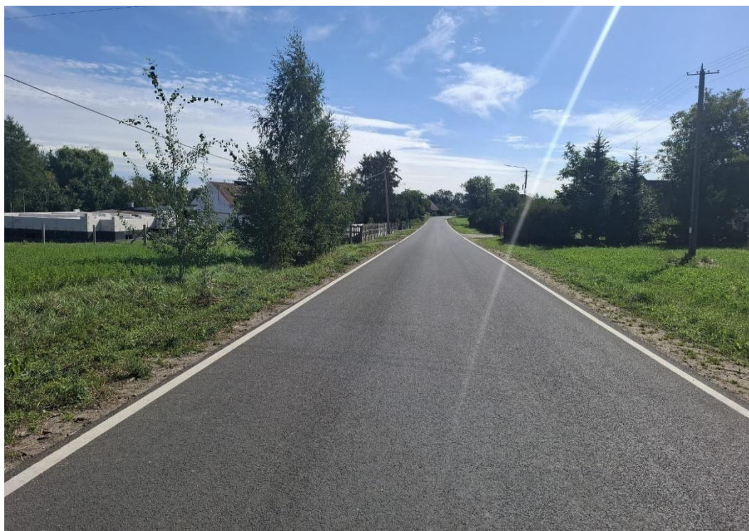
Fot. nr 14 Przebudowa dróg powiatowych nr 1244C Dąbrówka – Biechowo oraz 1246C Plewno – Belno, źródło: własne
