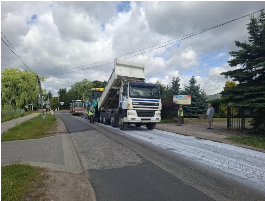
Fot. nr 30 Przebudowa odcinka drogi powiatowej nr 1260C Kozłowo - Przechowo, źródło: własne
