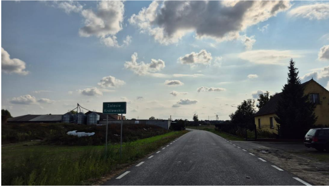
Fot. nr 24 Przebudowa drogi powiatowej nr 1041C Błędzim – Świekatowo, źródło: własne
