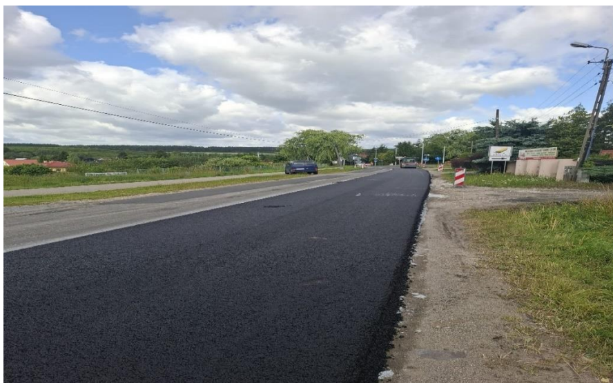
Fot. nr 31 Przebudowa odcinka drogi powiatowej nr 1260C Kozłowo - Przechowo, źródło: własne
