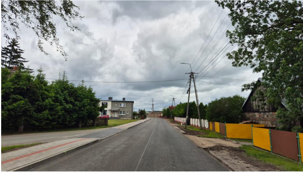
Fot. nr 20 Przebudowa drogi powiatowej nr 1041C Błędzim – Świekatowo, źródło: własne
