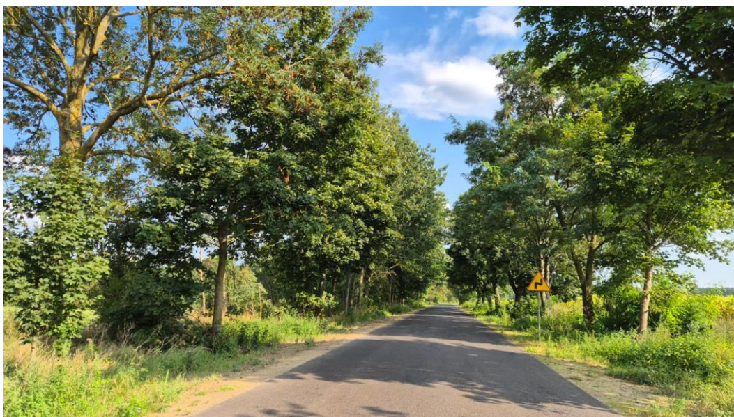
Fot. nr 29 Remont odcinka drogi powiatowej nr 1263C Świekatowo – Bukowiec, źródło: własne
